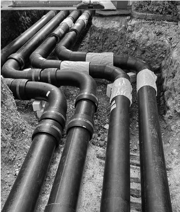
Rohre für die Fernwärme der Regionalwerke AG: Erstellung in Ennetbaden zwischen 2025 und 2027.
