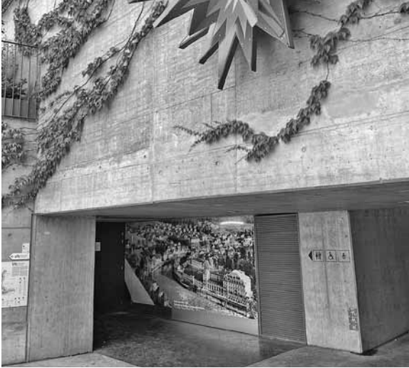
Unterer Eingang des Parkhauses Zentrum: Neue WC-Anlage.
