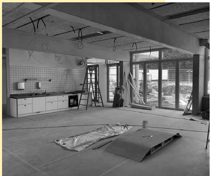
Innenraum im neuen Schulhaus: Arbeiten auf Hochtouren.
