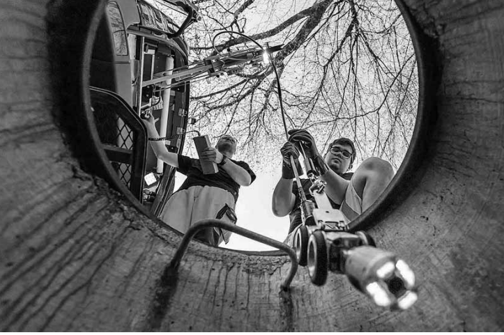
Kanal-TV: Grundlage für die Zustandserhebung.
