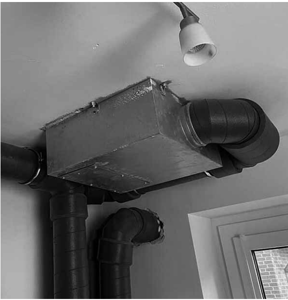
Wärmerückgewinnung: Massnahme zur Energieeinsparung.
