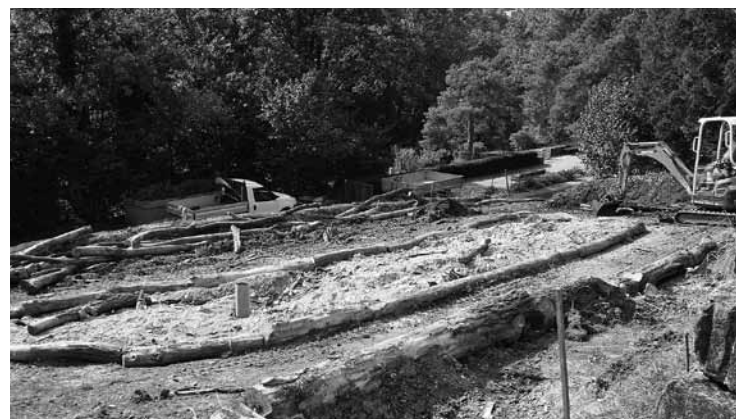
Bauarbeiten beim Friedhof: Strukturanpassungen.
