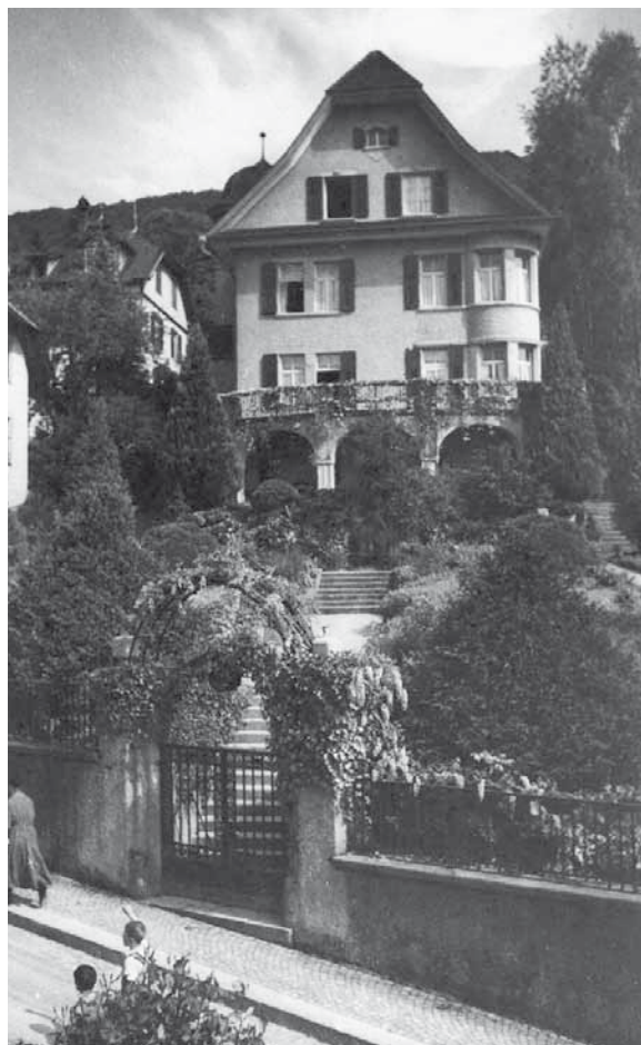
Villa Hohwies an der Grendelstrasse (1940): Grossbürgerlicher Haushalt.
