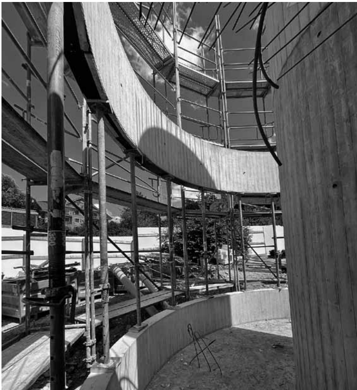
Rohbau des Treppenaufgangs: Schulhaus wird erkennbar.
