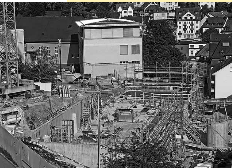
Baustelle Schulhaus Bachtal: Leichte Verzögerung.
