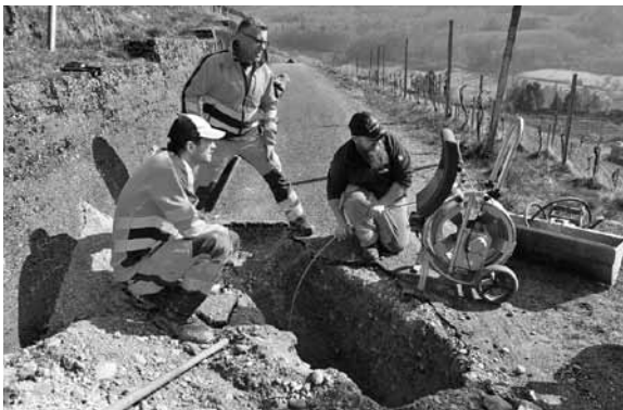
Werkdienst bei den Rettungsarbeiten: Spezielle Befreiungsaktion.
