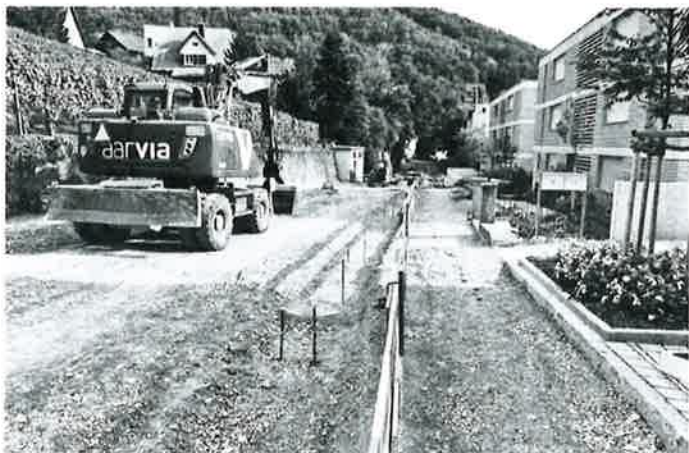
Baustelle der ersten Etappe der Sanierung Hertensteinstrasse: Ein komplexes Projekt.
