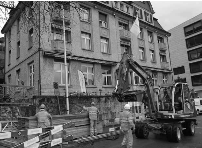
Bauarbeiten an der Badstrasse: Hohe Investition.
