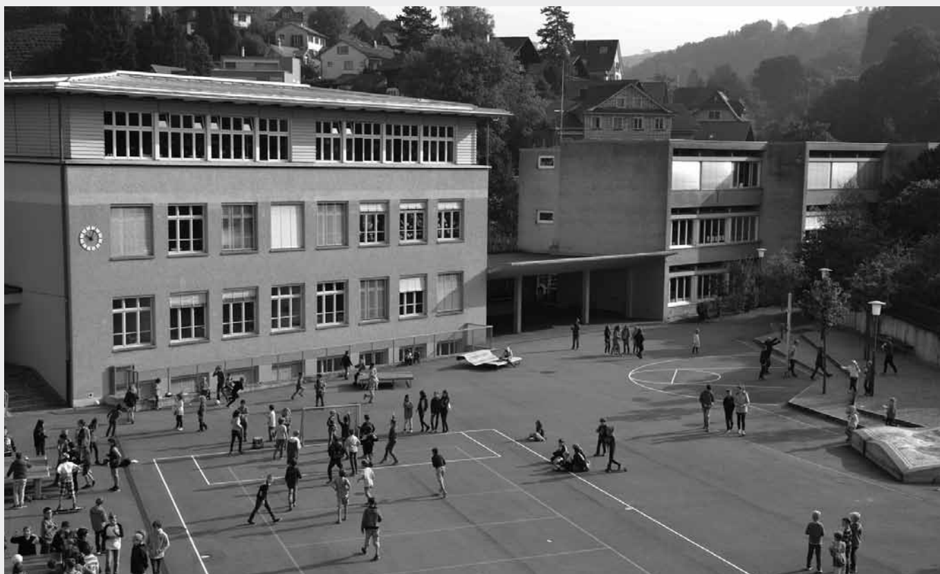
Ennetbadener Schülerinnen und Schüler vor den Schulhäusern 37 (links) und 64: Dringend sanierungsbedürftig.
