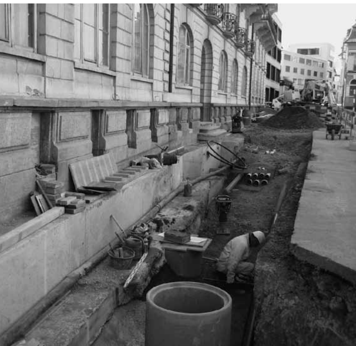
Baustelle beim Schwanen: Attraktivitätssteigerung für das Bäderquartier.
