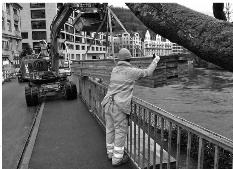
Arbeiten an der Ennetbadener Badstrasse: Komplexe Baustelle.
