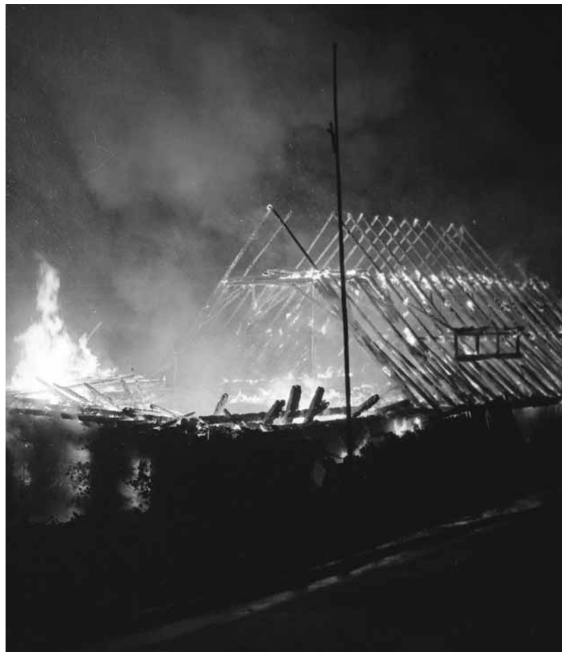
Dachstock der Spitaltrotte im Vollbrand: Wer übernimmt welche Kosten für den Wiederaufbau?
