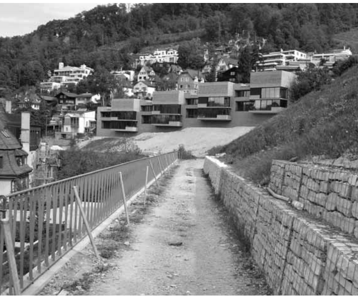
Tunnelweg: Bald durch eine Grünzone.
