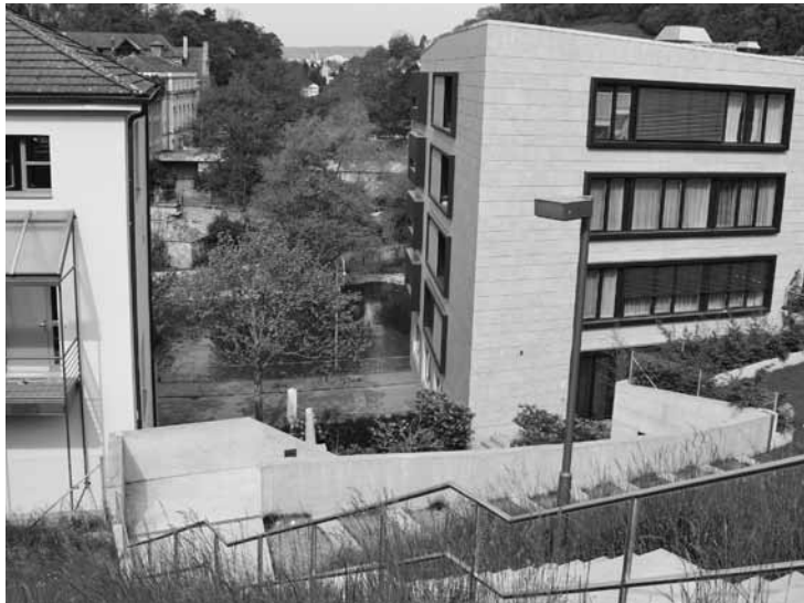
Treppenverbindung an die Hertensteinstrasse: Neu und saniert.
