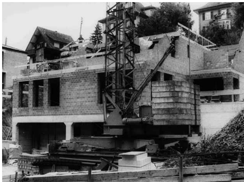
Bau des reformierten Ennetbadener Kirchgemeindehauses 1986: Wunsch nach mehr Eigenständigkeit.
