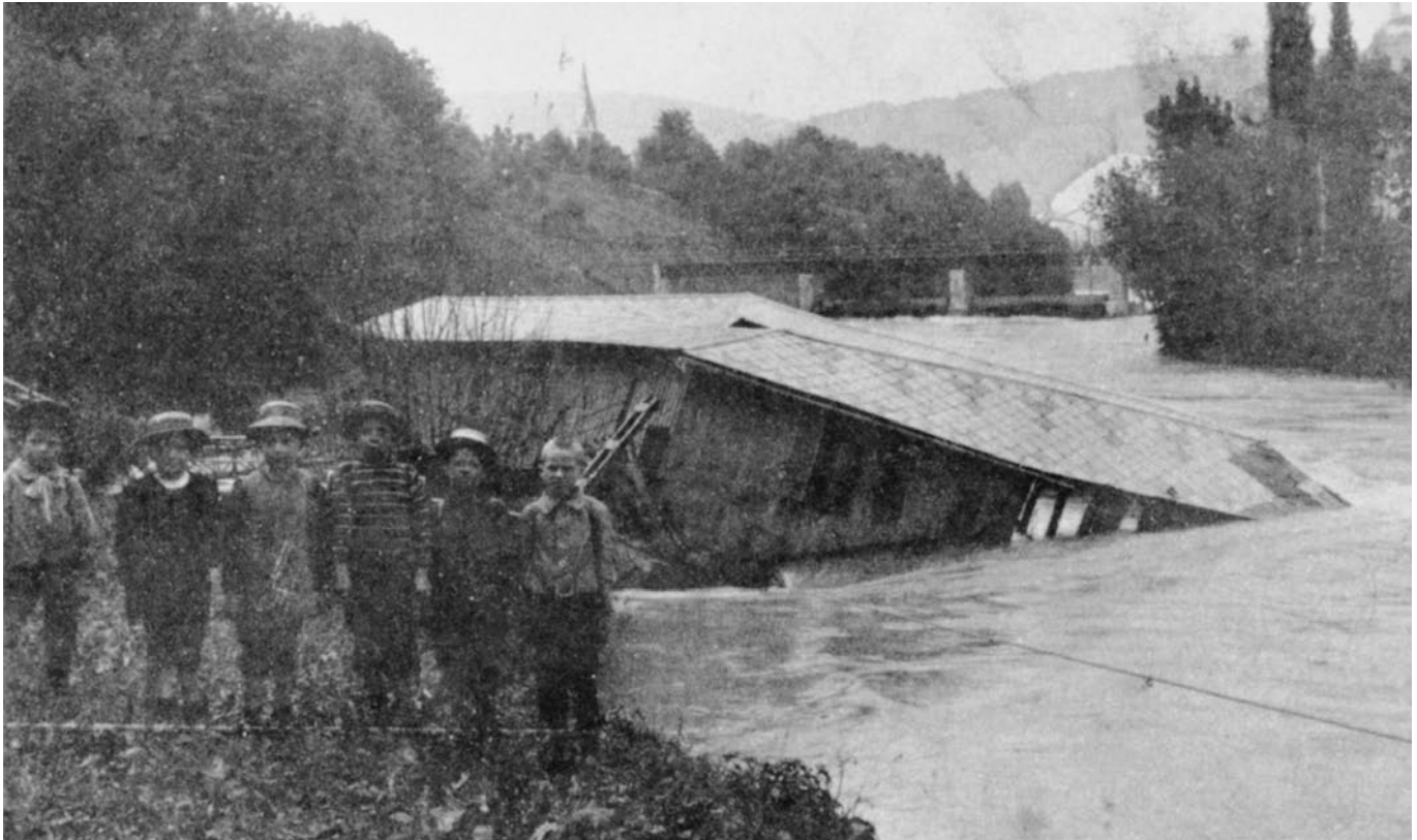
Zerstörte Badener Badeanstalt (nach dem Hochwasser vom Juni 1910): «Der Fluss bot einen schaurig-grossartigen Anblick.»
