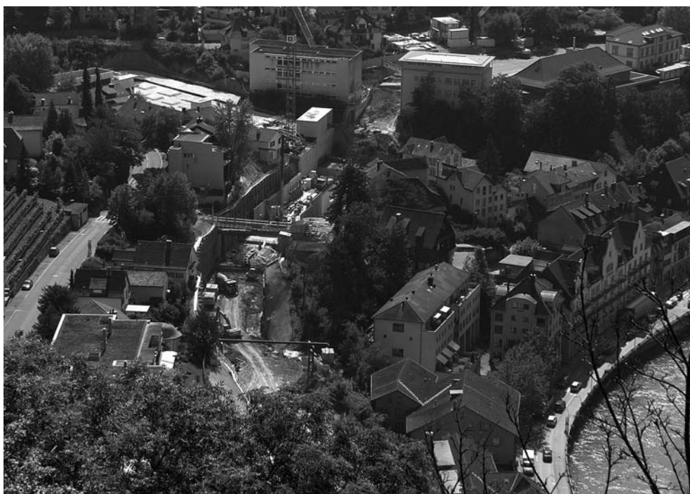
Schneise durchs Dorf: Tunnelbaustelle im September 2004.
