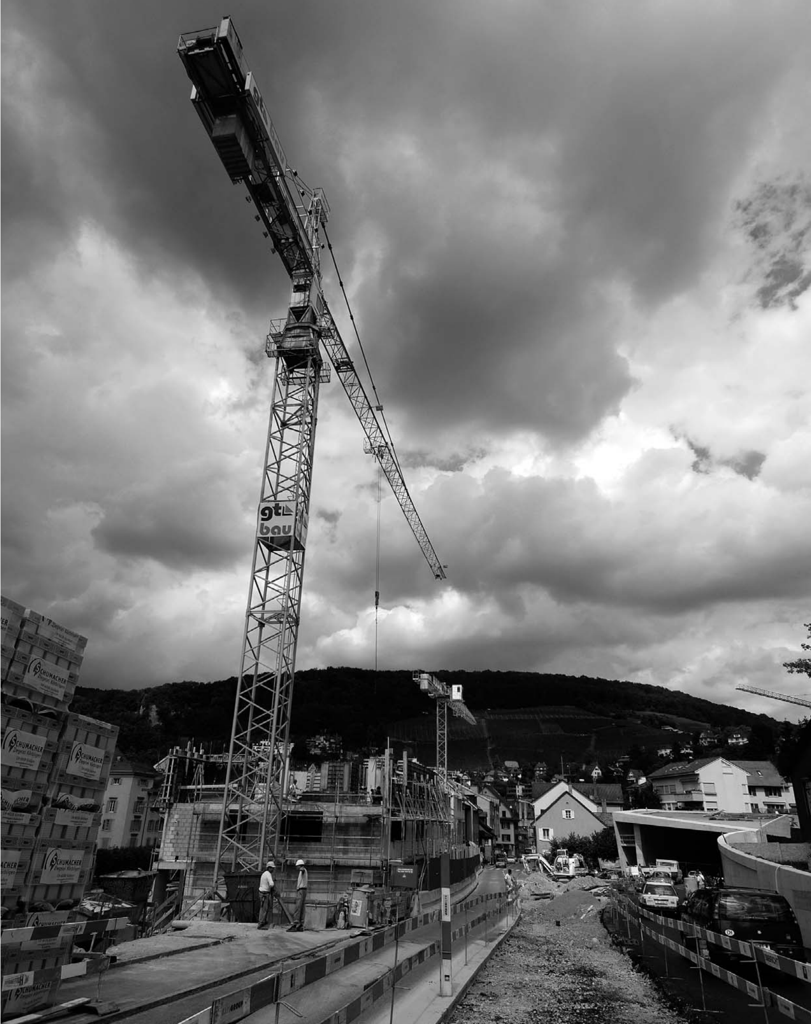
Baustelle beim Portal Grendel August 2006: Schlusspunkt hinter einer jahrzehntelangen Verkehrs- und Zentrumsplanung.
