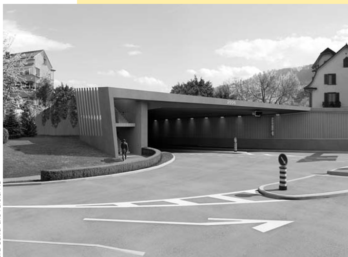
Portal Grendel im Endausbau.
