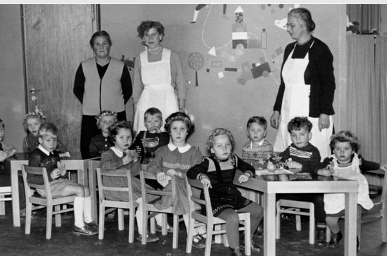
Kindergarten 1950: Befreiung aus Zwang und Unterdrückung.
