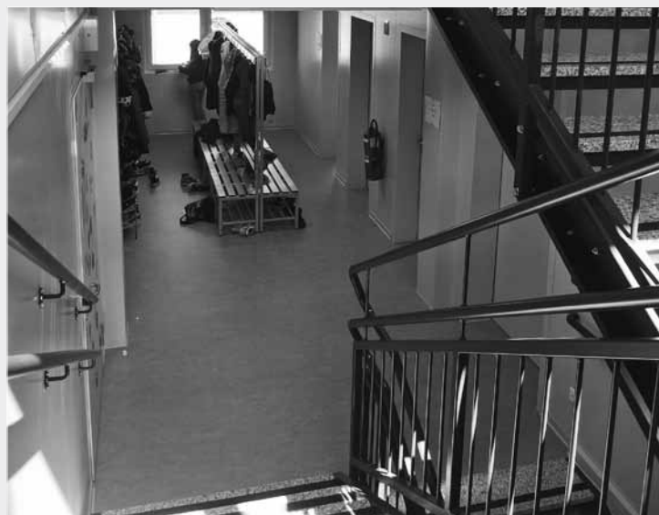
Treppenhaus im Provisorium: Ein «Upgrade».
