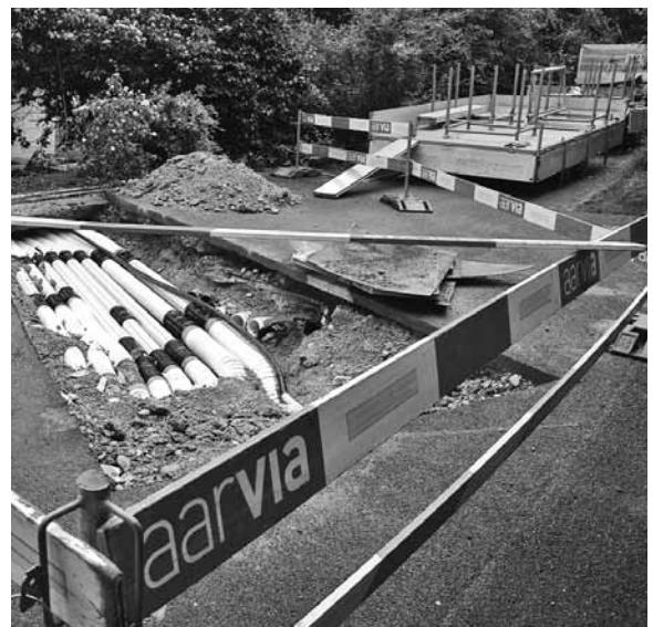
Umlegung der Kabelblöcke: Grossbaustelle kündigt sich an.
