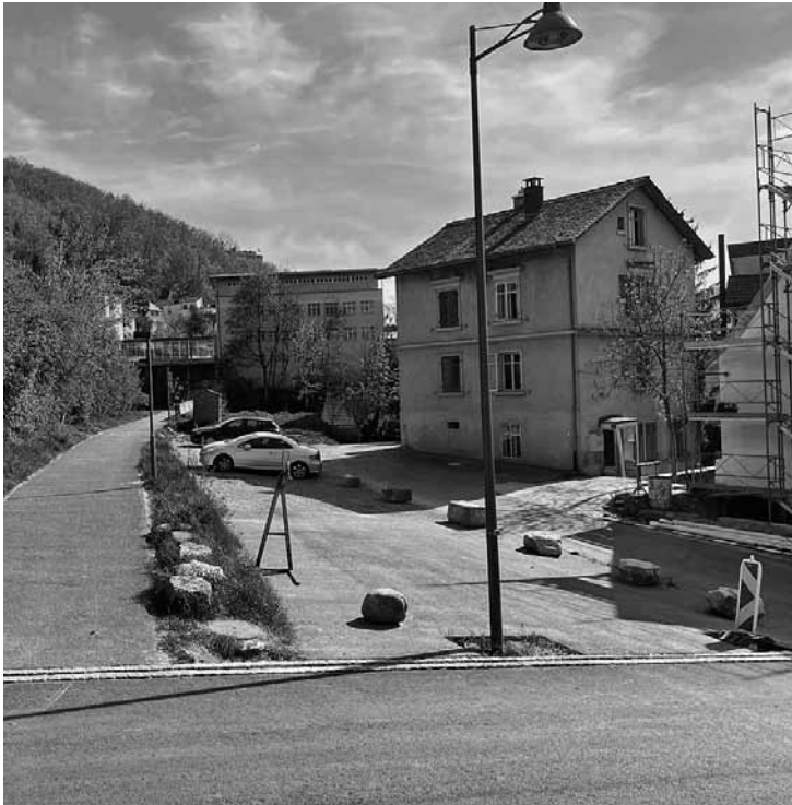
Geplanter Installationsplatz: Der Tunnelweg wird eingeschränkt.
