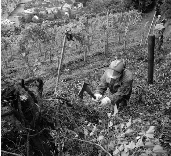
Zivilschützer bei den Abbruch- und Rodungsarbeiten: Abendstern endgültig erloschen.
