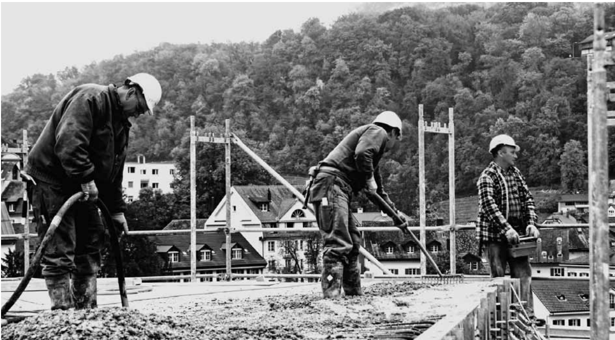
Bauarbeiter auf dem Dach des neuen Schulhauses: Oben angekommen.
