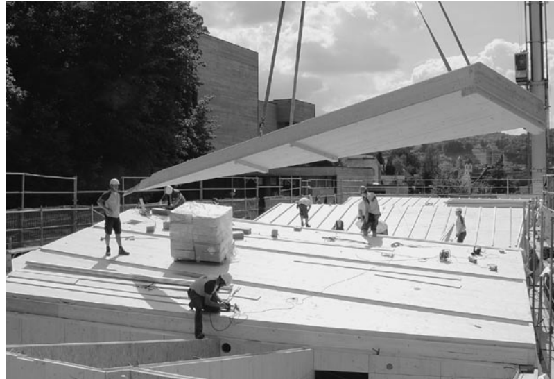
Montage der Fertigelemente für die Tagesstrukturen: Der Neubau nimmt Gestalt an.
